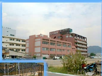
東館南側より
